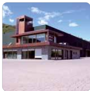
NEW PRODUCTION UNIT San Maurizio d'Opaglio (NO)
